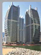
Armada Tower U.A.E
